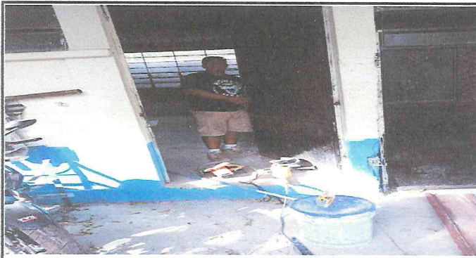
Foto 3: Sustitución de Chapas en puertas y marcos
