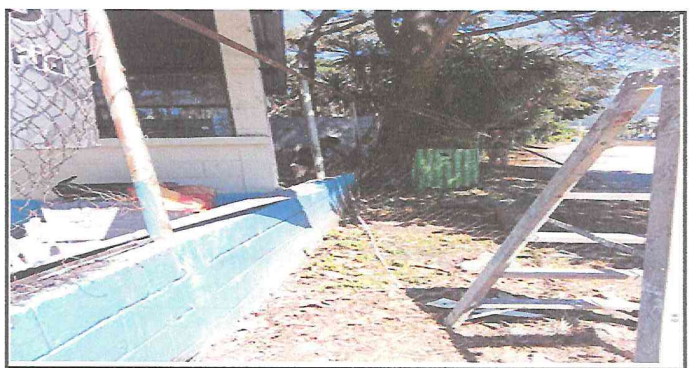
Foto 6: Desmontaje de maya parte de enfrente
